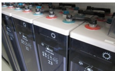
Batería Estacionaria BAE 16 PVS 3040
